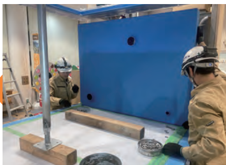
■側面板建て込み
